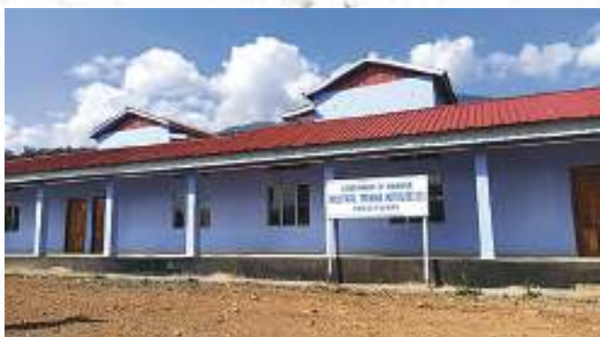
ITI Kangpoki, Manipur constructed under ESDI Scheme
